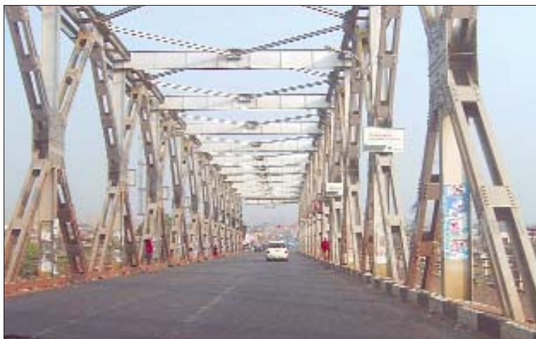
Onitsha: ponte sul Niger.
